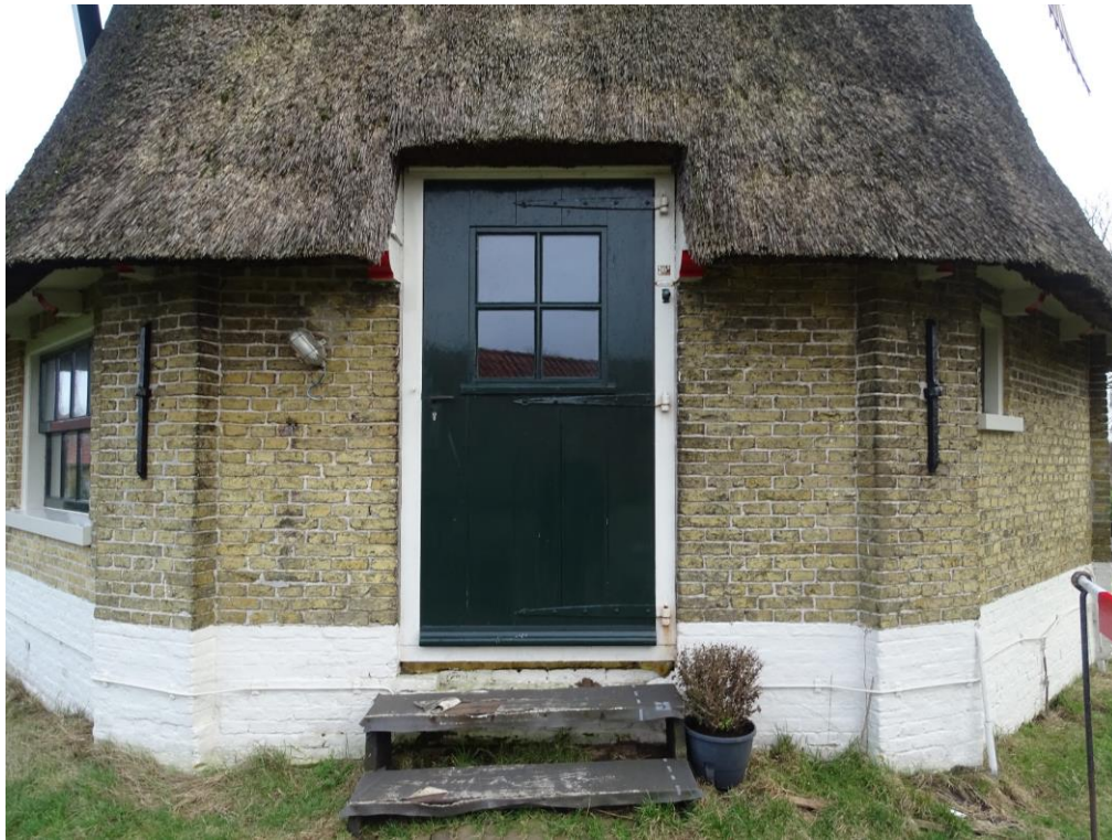
Foto 7. Overzicht van de veldmuren en entree deur.
