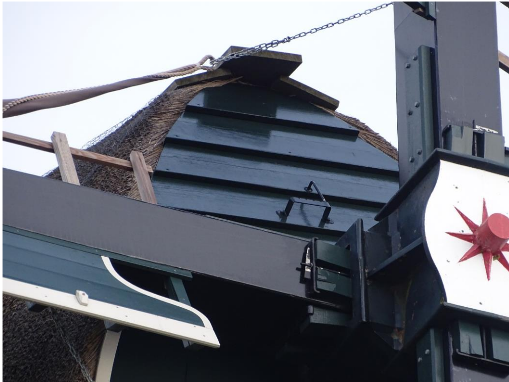
Foto 50. Overzicht van het stormschild.
