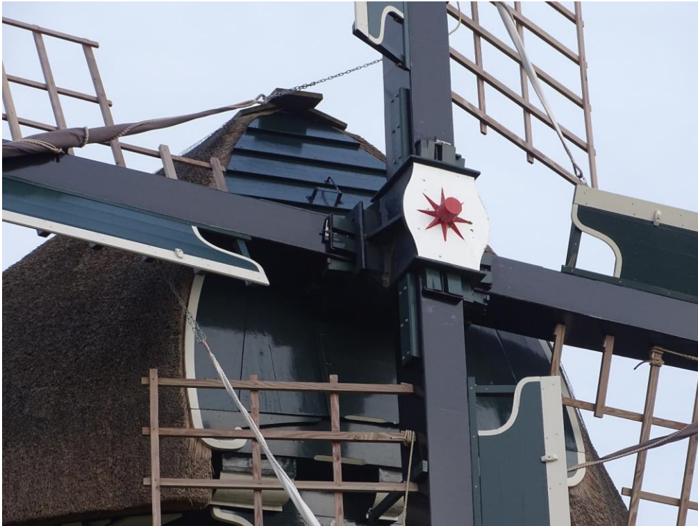
Foto 61. Overzicht van de askop met voorkeuvelens.
