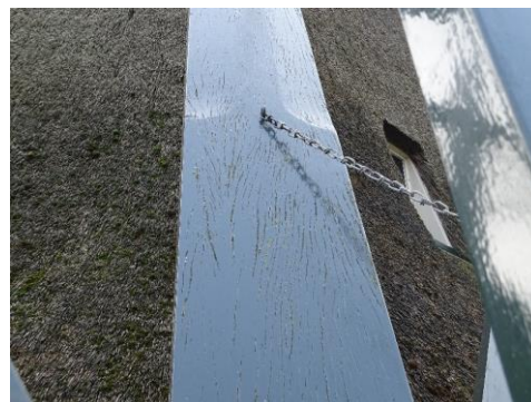
Foto 35 & 36. Detail van een verweerde plek op een lange schoor bij een noest en detail van de windscheuren op de staartbalk.
