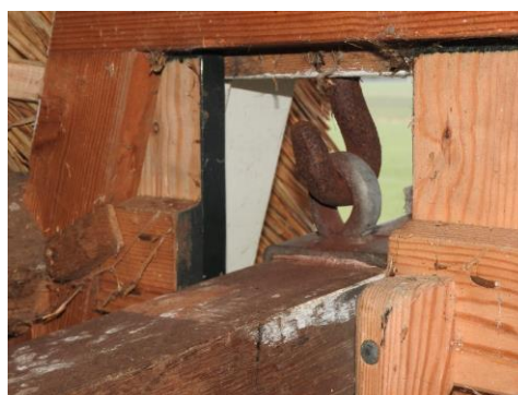
Foto 99 & 100. Detail van het sabelijzer, koebouten en de ophanging van de wipstok.
