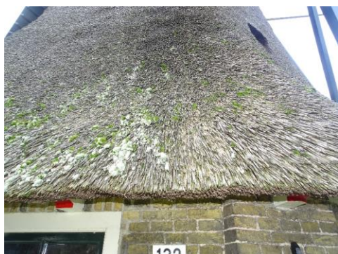
Foto 48 & 49. Detail van diverse mossen op de romp en een overzicht van de kap.
