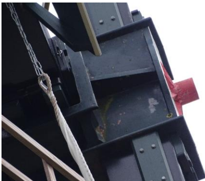
Foto 62 & 63. Detail van plaatselijke onthechting op de askop en overzicht van één end
