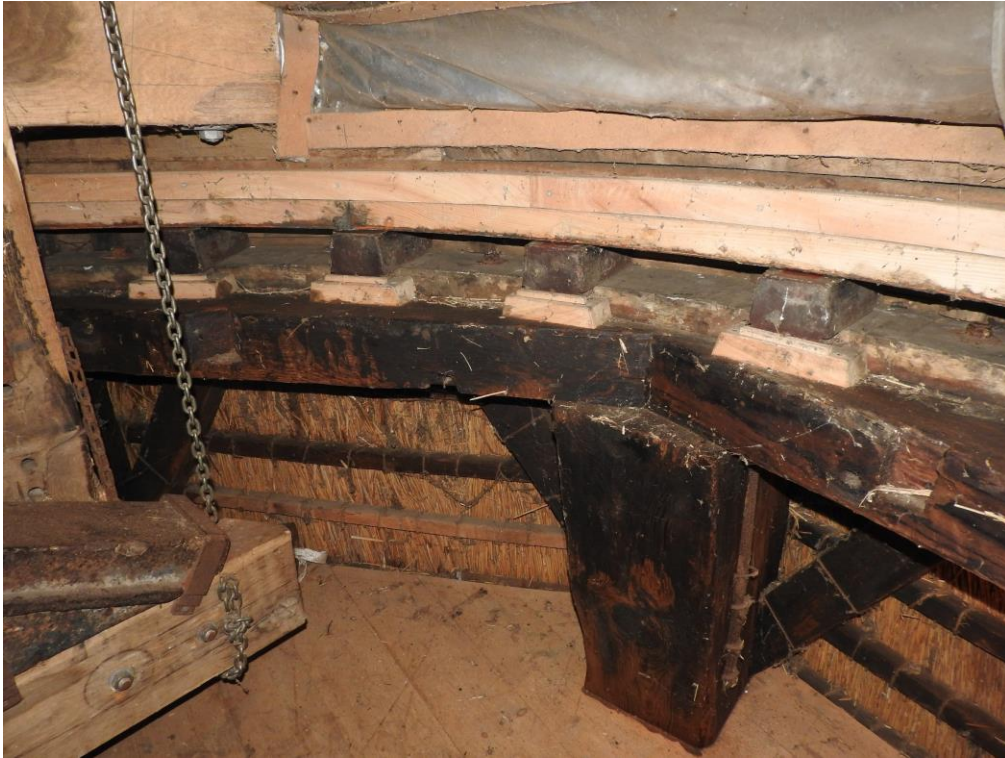
Foto 40. Overzicht van een deel van het neutenkruitwerk.
