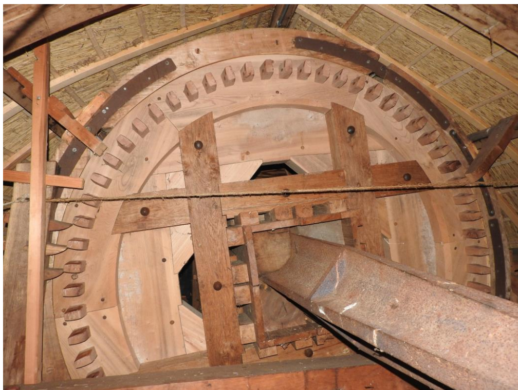
Foto 11. Overzicht van het bovenwiel in de kap.
