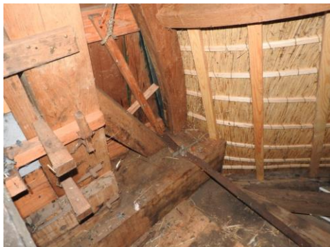
Foto 38 & 39. Details van de windpeluw en een voeghoutkop aan de voorzijde.
