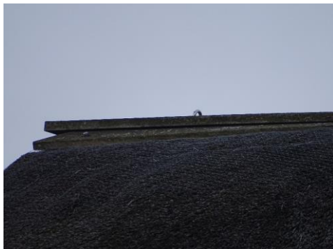
Foto 51 & 52. Detailfoto's van de molplanken.
