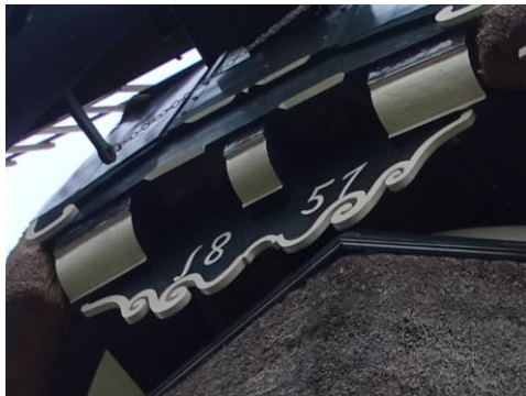
Foto 59 & 60. Overzicht van de baard en detail van één van de hammen.
