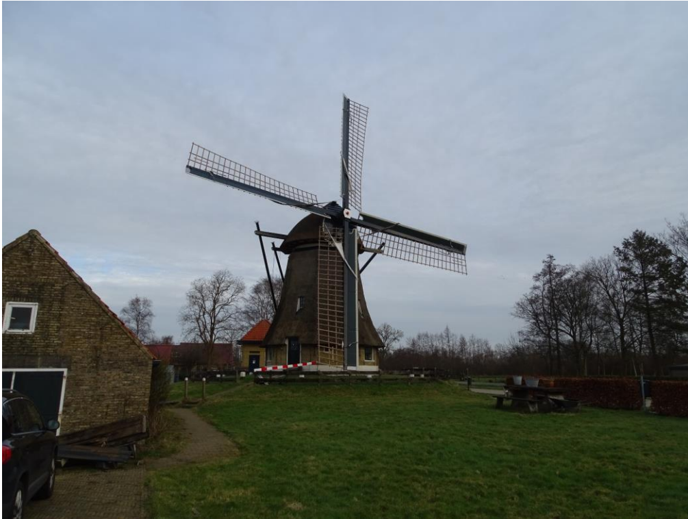
Foto 3. Overzicht van de molen vanuit het zuidwesten.
