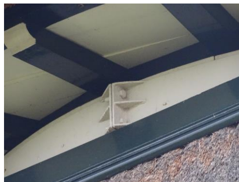
Foto 41 & 42. Overzicht van de neuten en een detail van de band om de keerkuip.
