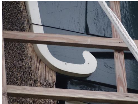
Foto 59 & 60. Overzicht van de baard en detail van één van de hammen.
