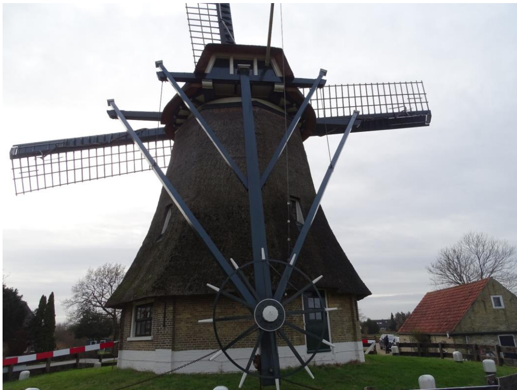
Foto 8. Overzicht van de staartconstructie en het achterkeuvelens.
