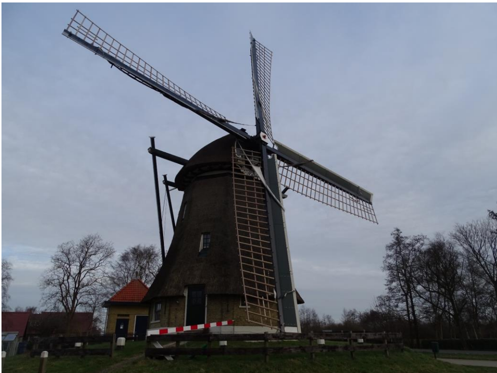
Foto 4. Overzicht van de molen vanuit het zuidwesten.
