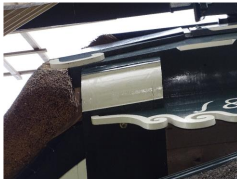
Foto 38 & 39. Details van de windpeluw en een voeghoutkop aan de voorzijde.
