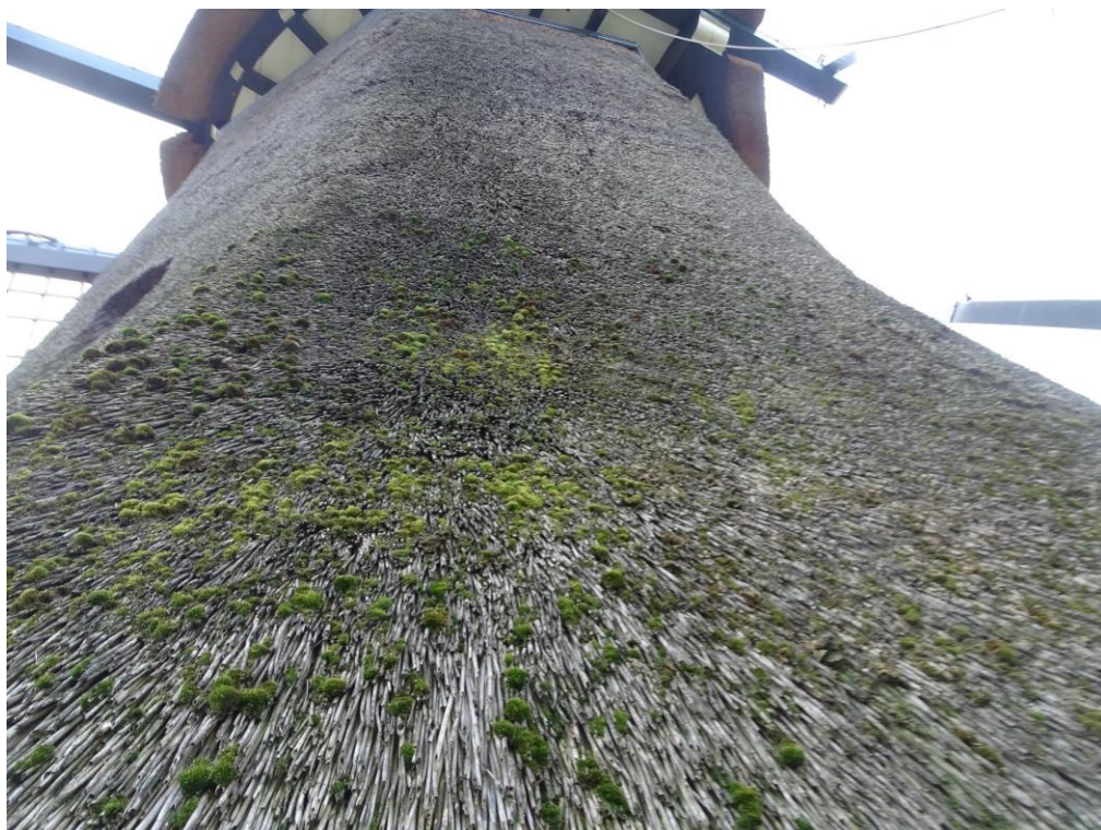
Foto 47. Detail van mosgroei op de rompbekleding.
