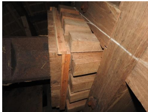
Foto 96 & 97. Detail van de beet en de wiggen van het bovenwiel.
