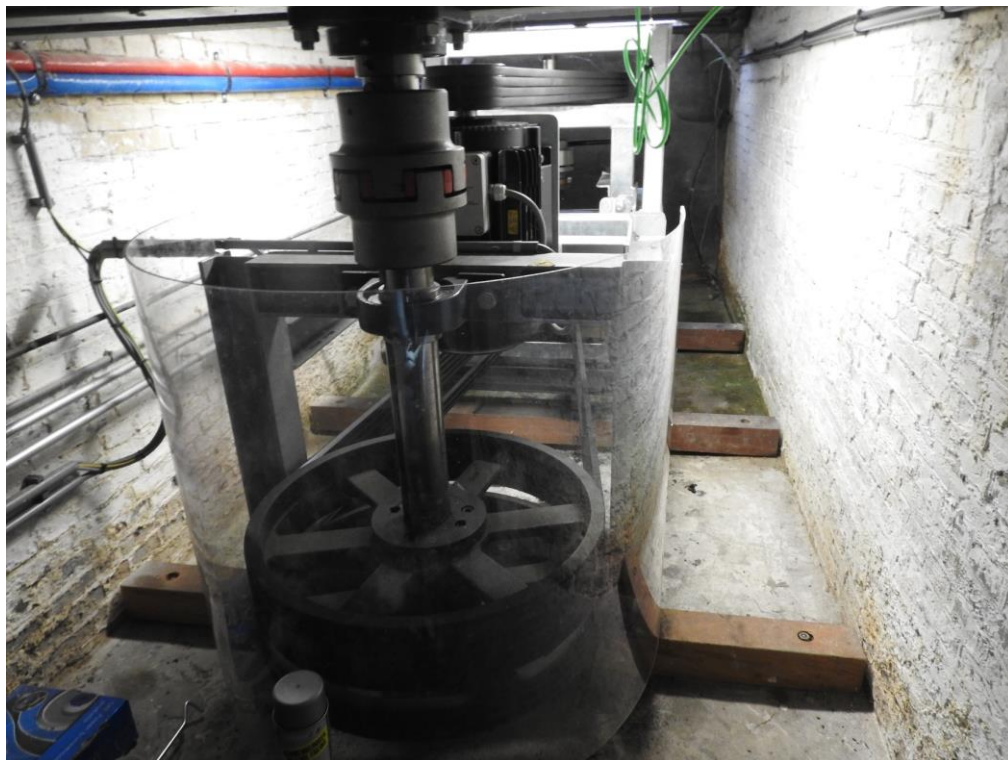
Foto 21. Overzicht van de voormalige waterloop.
