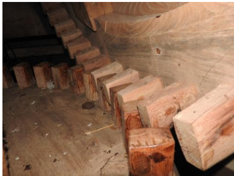
Foto 96 & 97. Detail van de beet en de wiggen van het bovenwiel.
