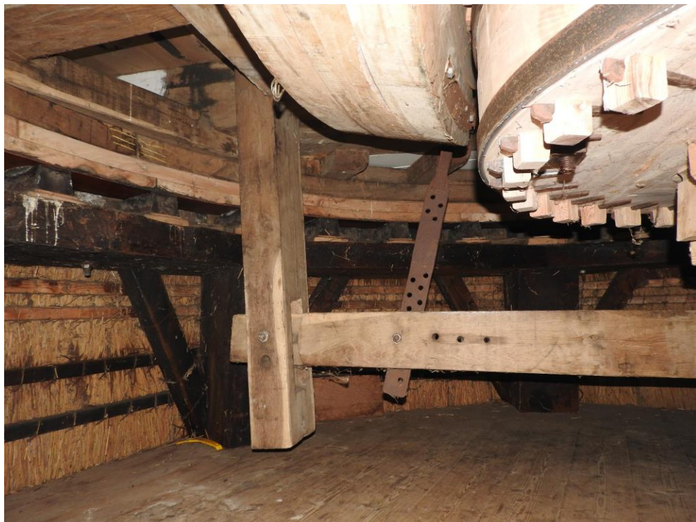
Foto 98. Overzicht van de vangbalk met ezel.
