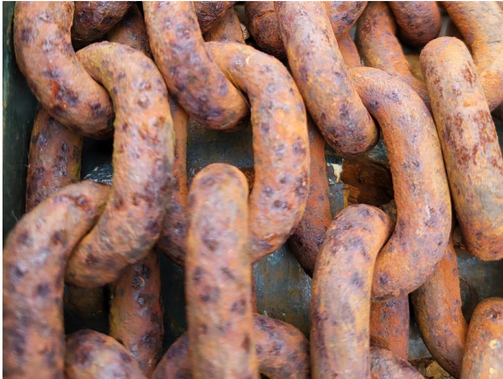
Foto 34. Detail van de houtrot aantasting onder de kruiketting.
