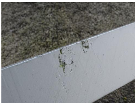
Foto 35 & 36. Detail van een verweerde plek op een lange schoor bij een noest en detail van de windscheuren op de staartbalk.
