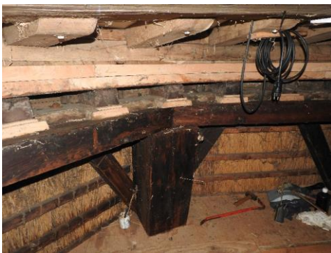
Foto 41 & 42. Overzicht van de neuten en een detail van de band om de keerkuip.
