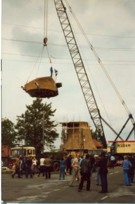
Juni 1981 De kap wordt op de romp getakeld.
